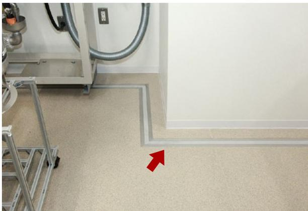
标准室的地基部分与新实验楼主体在结构上被“断边”分离，周围的振动难以直接传递到标准室中。间隙中填充硅橡胶，确保了安全性。
