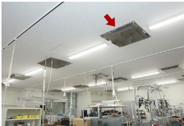
安装布满微孔的盖板（穿孔金属），空调吹出的空气不会集中在狭小范围内。
