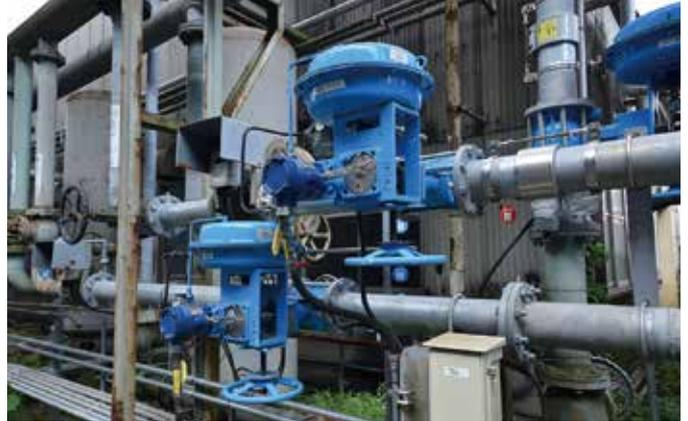
エア減圧制御に用いられ、工場ごとのエアの調節を行う偏心軸回転形調節弁。
