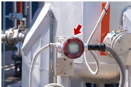
製品として出荷される生成油を貯めるタンクに取り付けられ、液面のレベル測定を行うリモートシール形差圧発信器。
