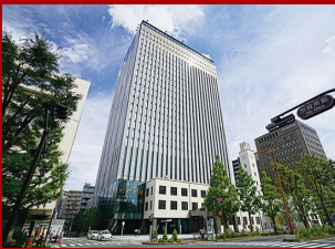
川崎市役所本庁舎
