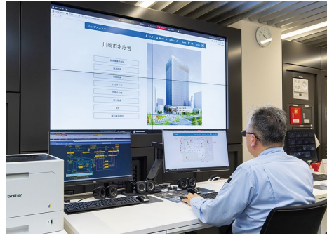
防災センターに設置されたsavic-net G5の監視画面。大型モニタに監視画面を映し出して関係者で一緒に確認することもできる。
