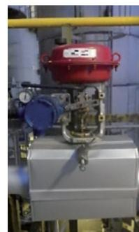
調節弁稼働データはクラウドへ送信され、CBMによる調節弁の整備計画策定を行う
