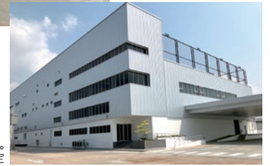
竣工したタイ新工場。電磁流量計他の生産ラインを構築予定
