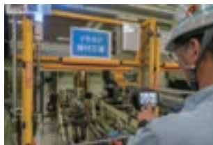
工場内の高所や人が入りにくい設備の中も、離れた場所からFLIR Si124でエア漏れを検知できる。
