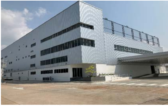
▲タイ生産子会社の新工場棟
